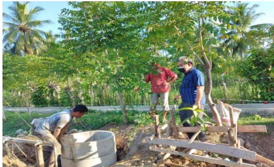
Gambar 8 Pembuatan Sumur Tahap II Pembangunan WC dan Kullah Air Lembaga Pendidikan Islam Dayah Tarbiyatul Muhtadin Gampong Ateuk Blang Asan Kabupaten Aceh Besar
