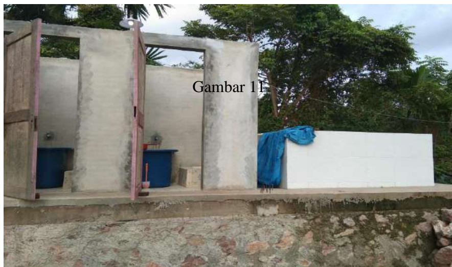
Gambar 4 Hasil Plaster tahap ke II Pembangunan WC dan Kullah Air Lembaga Pendidikan Islam Dayah Tarbiyatul Muhtadin Gampong Ateuk Blang Asan Kabupaten Aceh Besar
